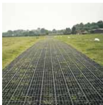
3. Verlegung ohne Unterbau
