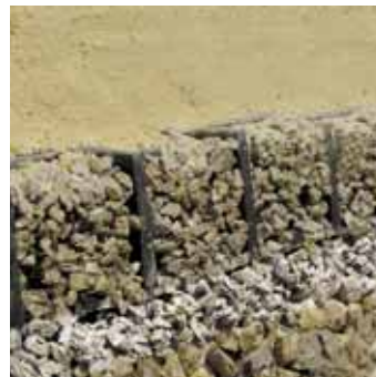
1. Verlegung mit Standardunterbau
